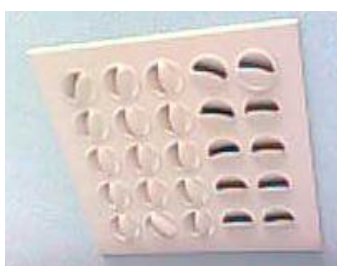
2. Kwadratowy nawiewnik z ruchomymi dyszami.
