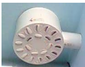
1. Okrągły nawiewnik sufitowy z zintegrowanymi skrzynkami rozprężnymi.
